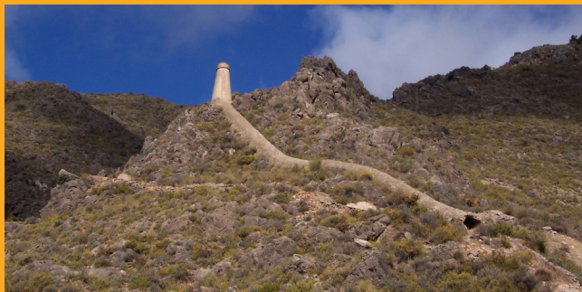
Fig.6 Chimenea de Nieles. Fuente: Ángel Bañuelos
